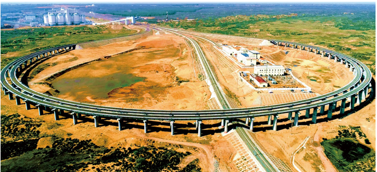
穿越矿区的靖神铁路
